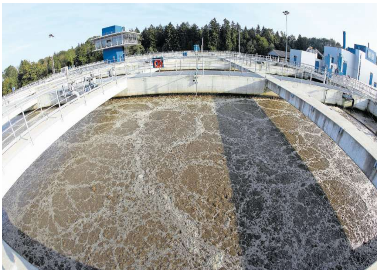
Das Belüftungsbecken der ARA Buholz mit Belebtschlamm.
